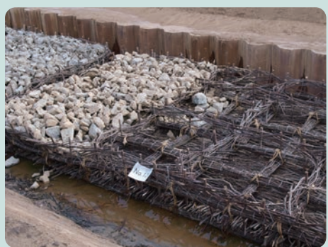
粗朶を格子状に組み、石を載せて川底に沈めます
