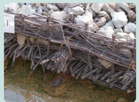
材料の隙間が、魚類などの生息場所として利用されます
