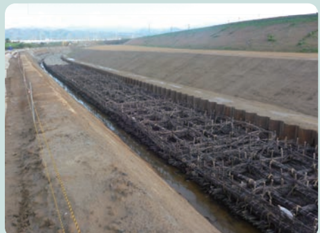
現在施工中の金屋地区の低水護岸工事では、粗朶沈床を採用しています
