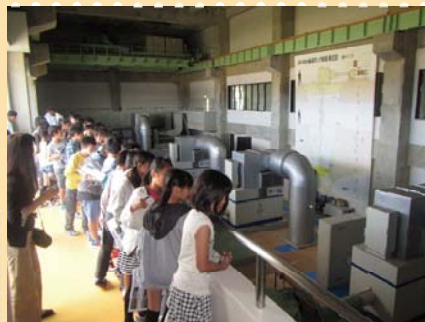
ポンプ室の見学の様子
