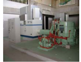
ポンプと原動機
