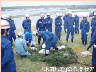
「木流し工」の作業状況
