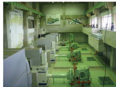
前川排水機場の見学
