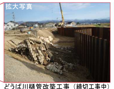
どうば川樋管改築工事（締切工事中）
