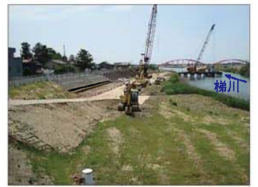
大川町耐震工事の様子
