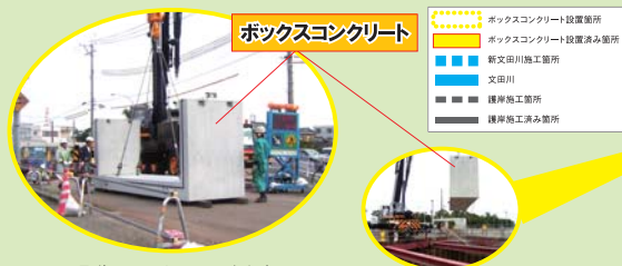
県道の下に文田川の水を流すためのボックスコンクリート
