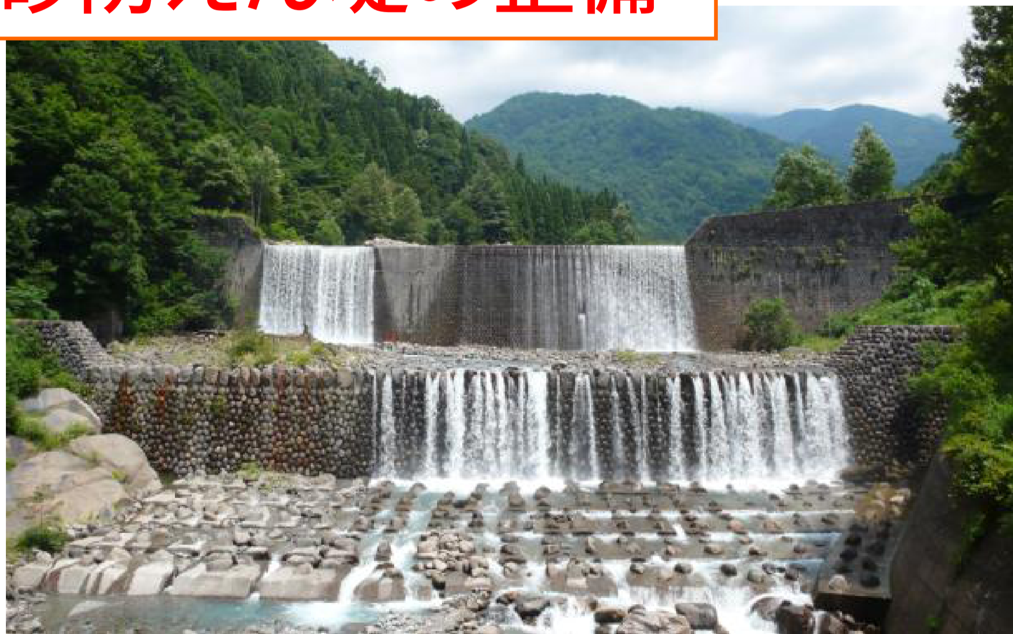
砂防えん堤の整備
