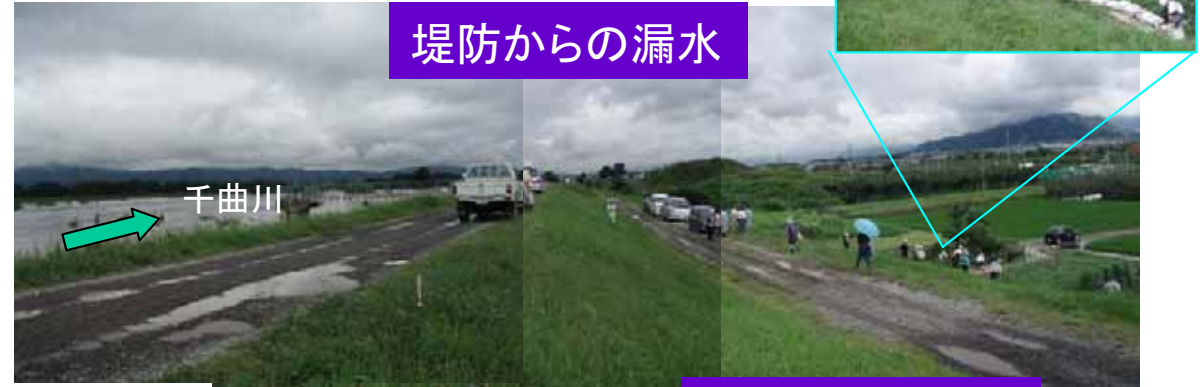
平成18年7月梅雨前線出水 漏水箇所 (千曲川:長野県 須坂市村山地先)
