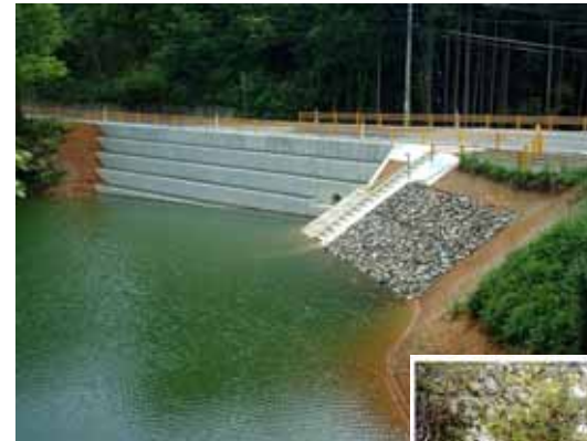
箱型擁壁無修景事例
