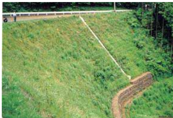
補強盛土事例
