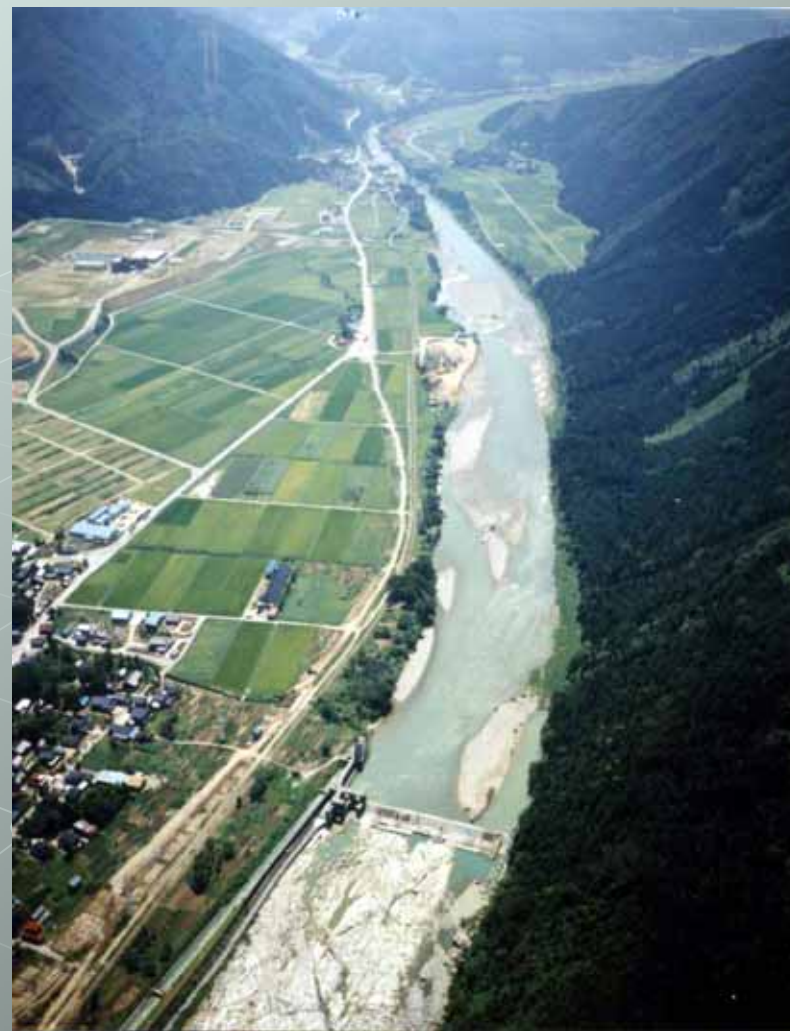
白山合口堰堤付近 (昭和56年8月撮影)
