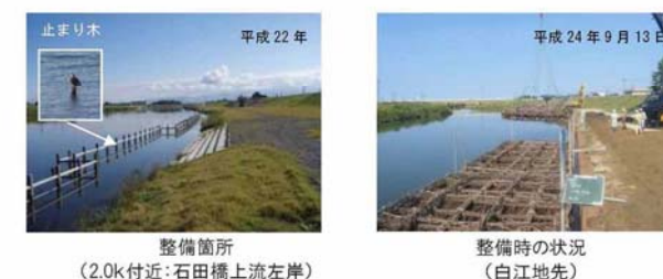
写真 5.1 低水護岸部における多自然川づくり
