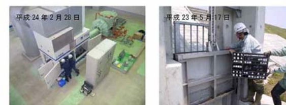
前川排水機場の排水ポンプ 樋管のゲート 写真 5.6 河川管理施設の点検状況
