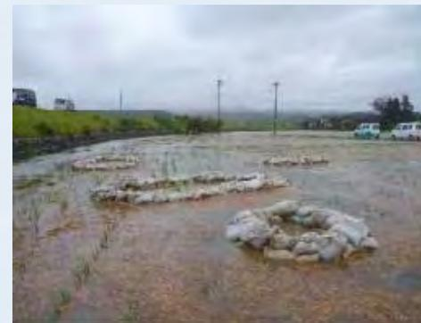
■堤防の法崩れ、漏水の事例（平成25年7月洪水）
