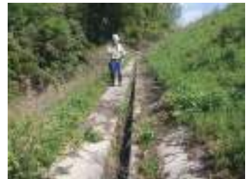
防災点検(法面等)
