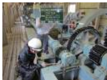
取水施設の定期点検
