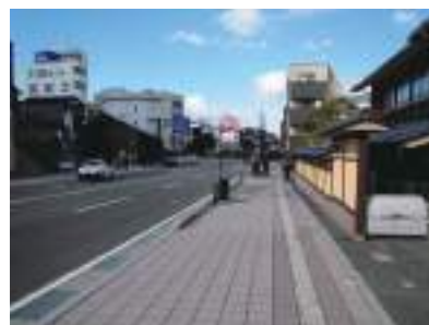
電線が地中化された電線共同溝 整備完了箇所（金沢市橋場町）
