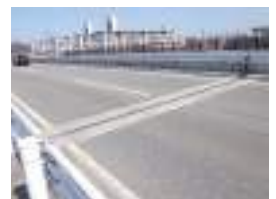
国道8号二日市跨線橋(上り) 伸縮装置交換
