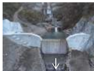
④ 柳谷中流砂防堰堤工事
