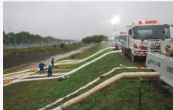
排水ポンプ班による排水作業（長野県小布施町）
