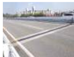
国道8号二日市跨線橋(上り) 伸縮装置交換
