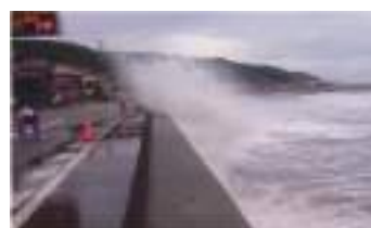
国道160号 越波による通行規制 （石川県七尾市大泊）
