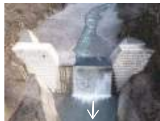
① 中ノ川第 1 号砂防堰堤改築工事
