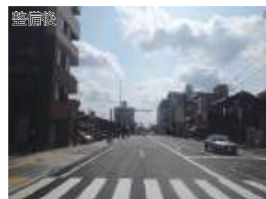
国道157号野町自転車歩行者道整備 (部分供用箇所)
