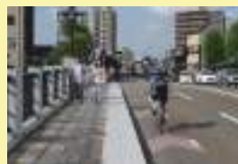
●自転車走行指導帯の設置 (国道159号)
