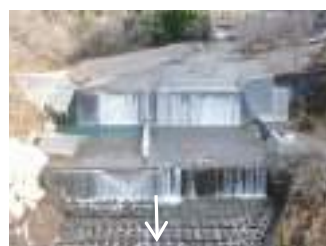
③ 市ノ瀬砂防堰堤改築工事
