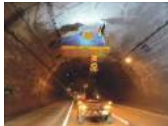
トンネル点検
