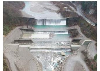
天然ダム対策としてスリット形式による土砂捕捉能力の強化を行います
