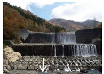
アンカー工法を用いた砂防堰堤の安定性の向上を行います
