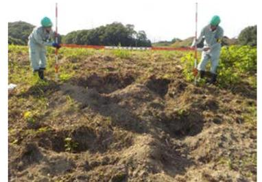
イノシシの掘り返しによる堤防の損傷
