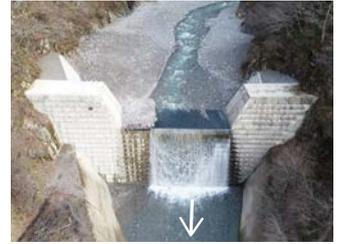
損傷した砂防堰堤の補修、嵩上げによる土砂捕捉能力の強化を行います
