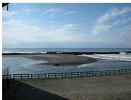
導流堤内の堆砂
