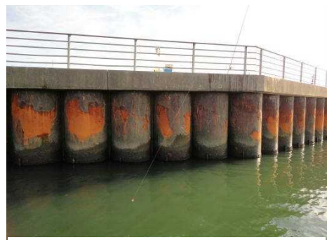
鋼管矢板護岸
