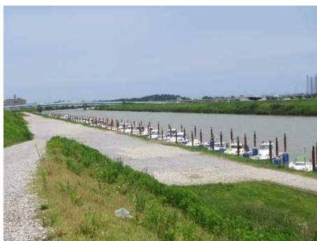
暫定係留施設
