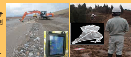
金沢河川国道事務所管内ではICTを積極的に活用
