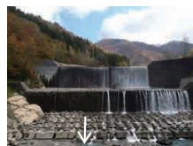
③市ノ瀬砂防堰堤改築工事
