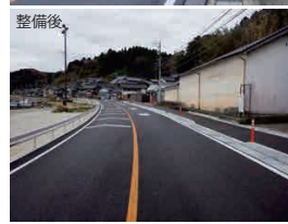
国道160号庵歩道整備・道路拡幅
