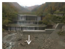
②赤岩砂防堰堤改築工事
