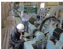
取水施設の定期点検
