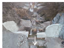
④柳谷中流砂防堰堤工事
