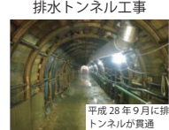
⑤基之助谷地すべり対策排水トンネル工事
