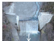
①中ノ川第1号砂防堰堤改築工事
