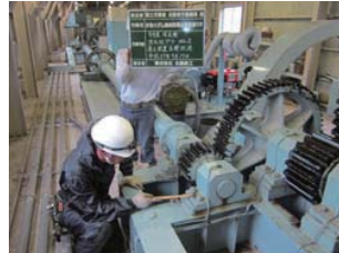
取水施設の定期点検
