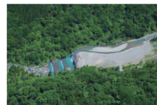
天然ダム対策としてスリット形式による土砂捕捉能力の強化を行います
