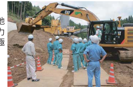
輪島道路現場見学会
