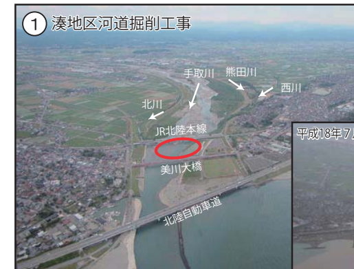
河道掘削による洪水時の通水能力向上
