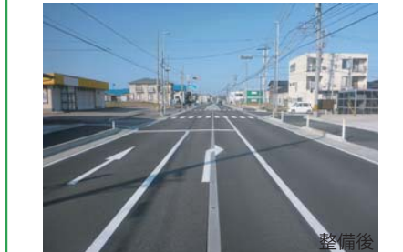
国道159号木津交差点改良事業 右折レーン設置・道路拡幅(歩道整備)
