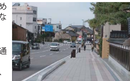
電線共同溝整備完了箇所 (金沢市橋場町)
