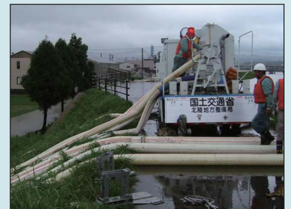
排水作業を行っている排水ポンプ車
