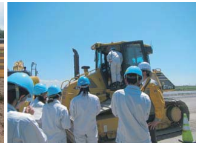
ICT活用工事現場見学会（手取川）
