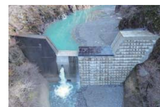
損傷した砂防堰堤の補修、嵩上げによる土砂捕捉能力の強化を行います
