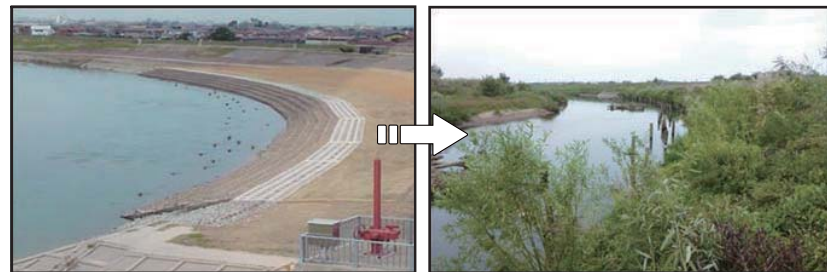
整備直後：護岸の上に土砂等を被覆 現況：植生が復元し、自然環境が回復
