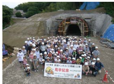
金沢東部環状道路(山側環状) 卯辰トンネル(期線)工事現場 (平成23年6月)
