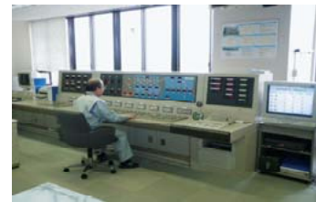
前川排水機場の操作室
