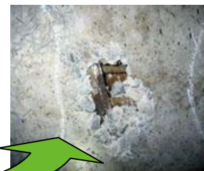
コンクリートが剥がれ、鉄筋の一部が見えている。
