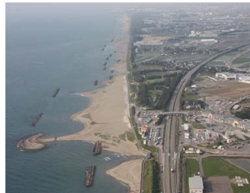
松任工区 白山市徳光町地先状況写真
