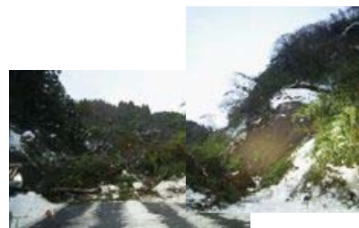
国道160号七尾市庵町の被災状況
