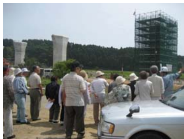
七尾水見道路(能越自動車道) 熊淵川橋工事現場 (平成23年6月)
