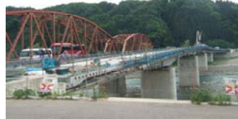
手取川に架橋中の天狗橋(許可工作物)
