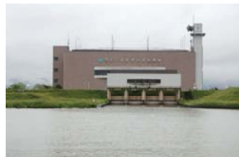
前川排水機場
