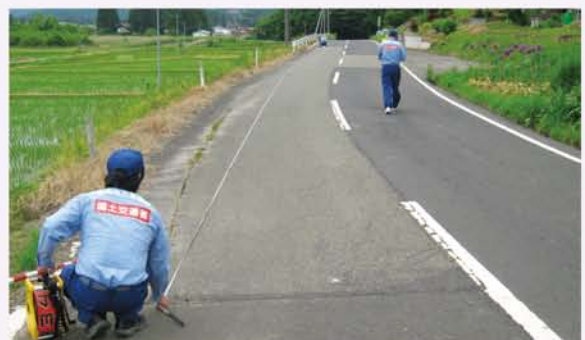
平成20年6月14日 岩手・宮城内陸地震の現場で現地調査にあたるTEC-FORCE隊員
