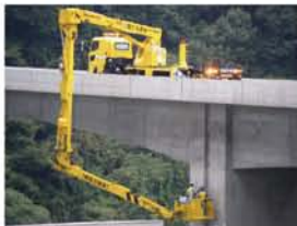
橋梁点検車により定期的に行う橋梁点検
