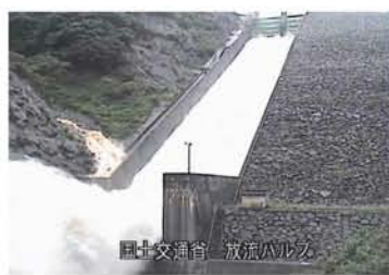
洪水調節を行っている手取川ダム (平成18年7月豪雨)
