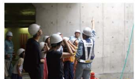
武蔵地下道工事現場 (平成20年8月26日 金沢地区道路体験学習)
