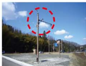
道路テレメーター (気温・雨量・積雪量・風向など)
