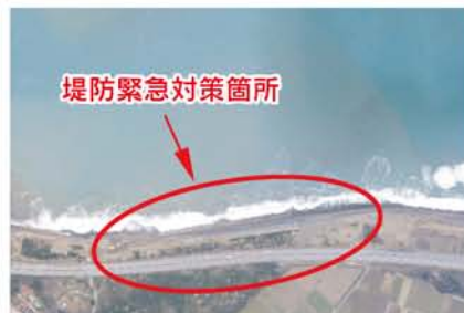
①片山津工区堤防緊急対策箇所(平成19年1月撮影)
