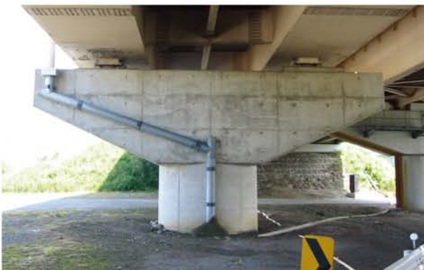
補強前/地震に対して弱いものもある古い橋梁
