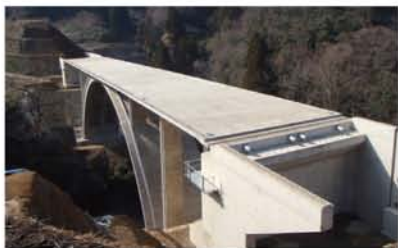
七尾市麻生町付近の工事状況
