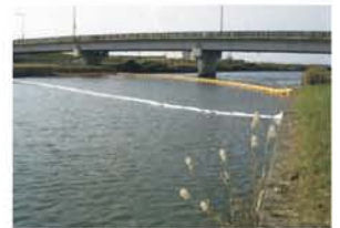
平成20年11月16日に八丁川及び梯川に流出した灯油の回収
