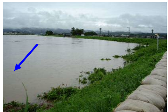
写真 2.11 白江大橋上流左岸の状況
