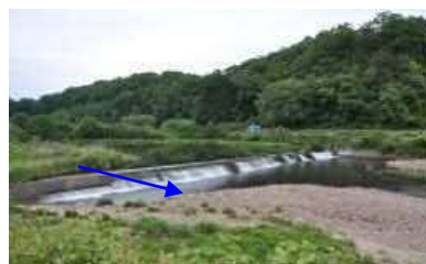
写真 2.14 軽海用水頭首工
