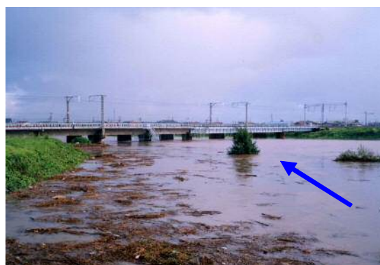
写真 2.9 JR北陸本線梯川橋梁の状況 (平成10年9月22日撮影)
