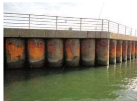
写真 5.5 鋼矢板の状況
