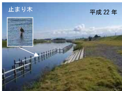
整備箇所 (2.0k付近:石田橋上流左岸)
