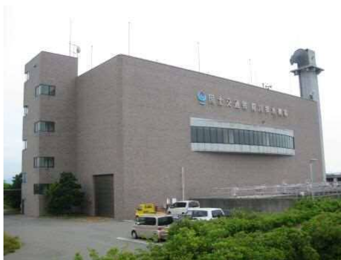
写真 3.4 前川排水機場
