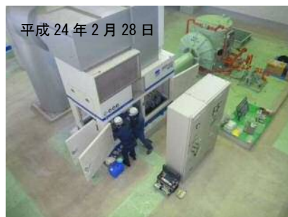
前川排水機場の排水ポンプ
