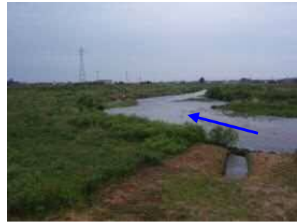
湾曲部の状況(8.6k 付近)
