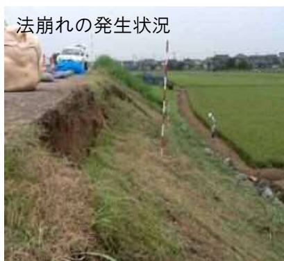
写真 3.3 堤防の法崩れ、漏水の事例（平成 25 年 7 月洪水）
