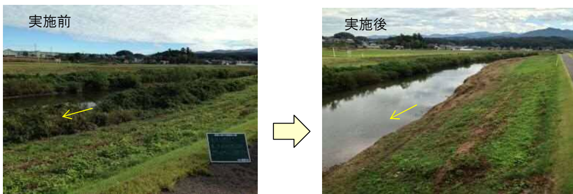
写真 3.5 河道内樹木の伐採前後の状況
