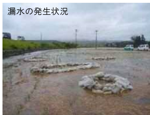
写真 3.3 堤防の法崩れ、漏水の事例（平成 25 年 7 月洪水）
