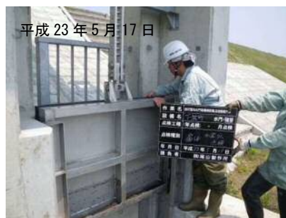
樋管のゲート
