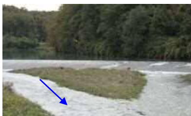
写真 2.13 御茶用水頭首工
