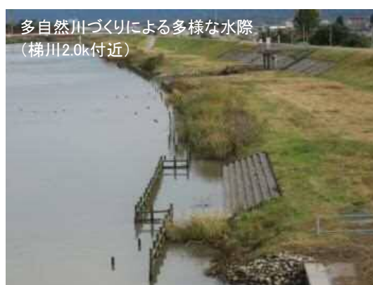
写真 3.13 下流部の水際の状況（平成 23 年 4 月撮影）
