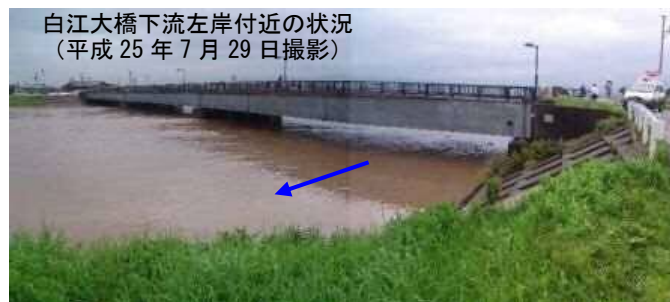
写真 3.2 平成 25 年 7 月洪水の白江大橋付近の水位上昇
