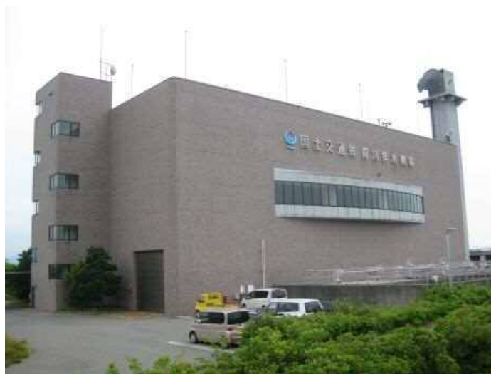
写真 3.4 前川排水機場
