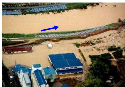
写真 2.10 小松市埴田町地先の内水湛水状況 (平成16年10月20日撮影)
