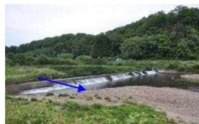
写真 2.14 軽海用水頭首工
