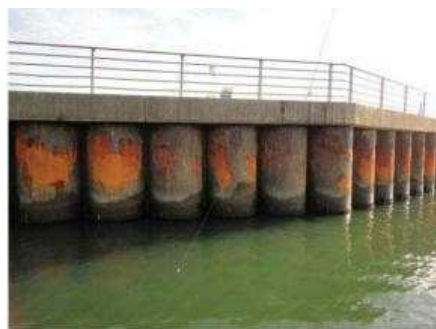
写真 5.5 鋼矢板の状況
