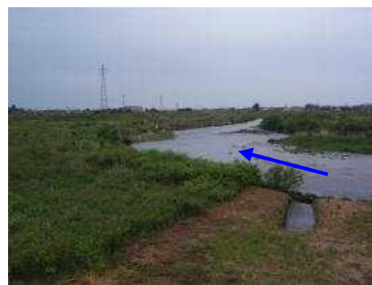
湾曲部の状況(8.6k 付近)
