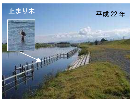
整備箇所 (2.0k付近:石田橋上流左岸)
