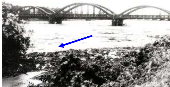
写真 2.8 梯大橋下流の状況
