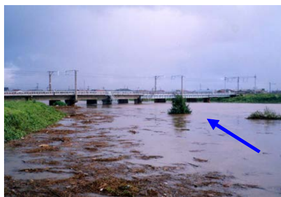
写真 2.9 JR北陸本線梯川橋梁の状況
