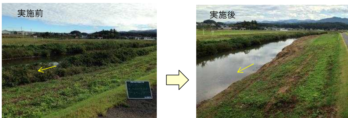
写真 3.5 河道内樹木の伐採前後の状況
