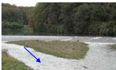
写真 2.13 御茶用水頭首工
