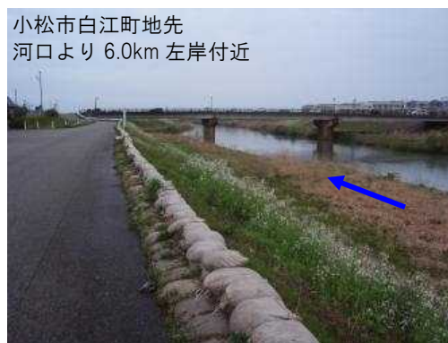
写真 3.1 白江大橋上流付近の暫定堤箇所の状況
