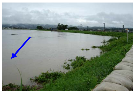
写真 2.11 白江大橋上流左岸の状況 (平成18年7月17日撮影)
