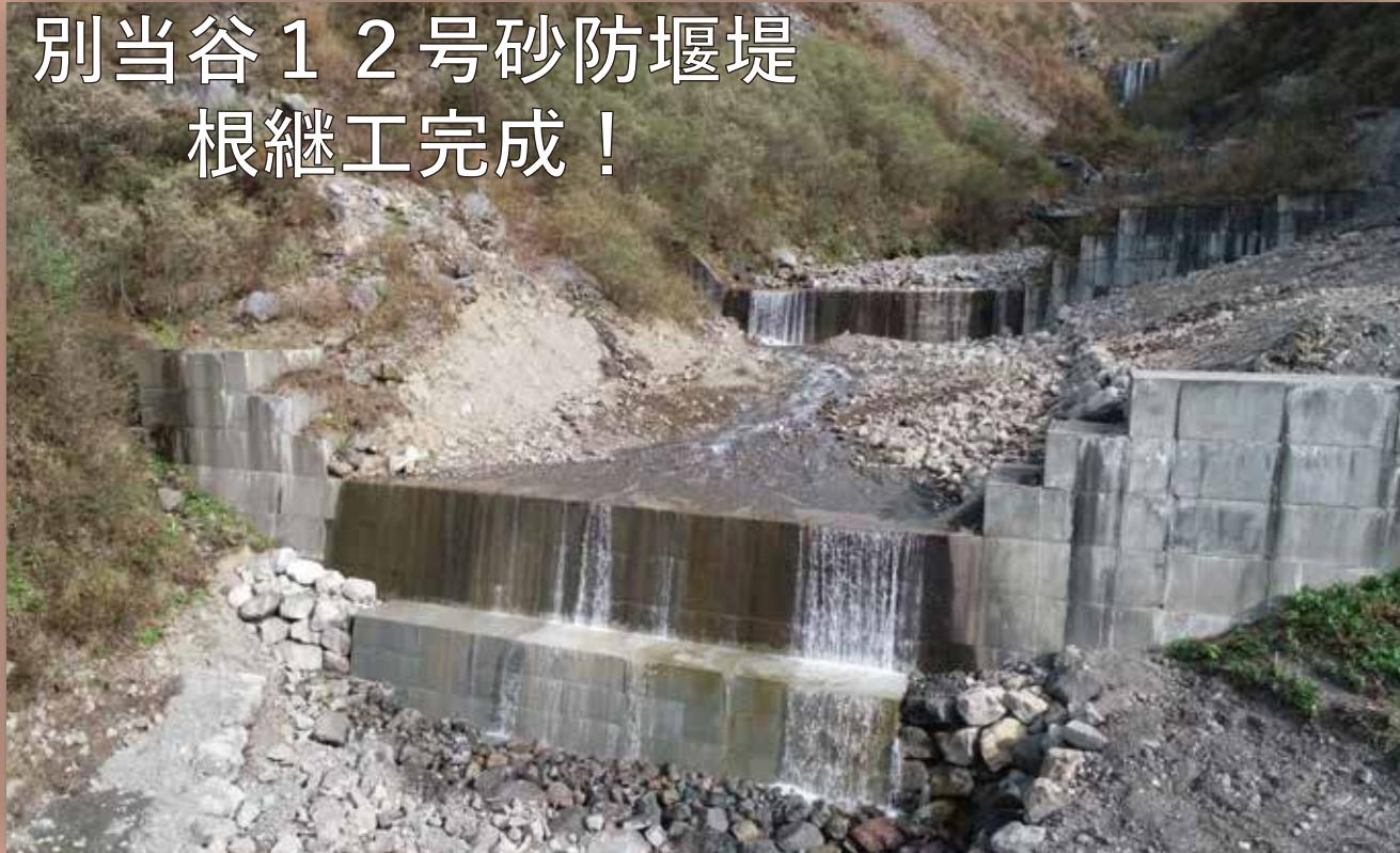
手取川上流の別当谷にある別当谷第12号砂防堰堤は、昭和45年に完成した高さ6m、長さ77mの砂防堰堤です。平成16年5月に発生した土石流で被災し、復旧工事として下流腹付工が実施されましたが、急峻な河床勾配のため、その後渓床堆積土砂の流出により渓床が低下し、基礎部が洗掘されていました。
