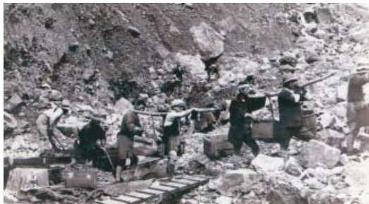
コンクリート用骨材を桶に入れ、人力で運搬している様子。昭和3年撮影
