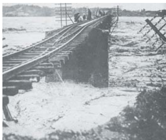
国鉄(現JR)手取川橋梁の被害状況 出典:金沢工事事務所治水事業のあゆみ
