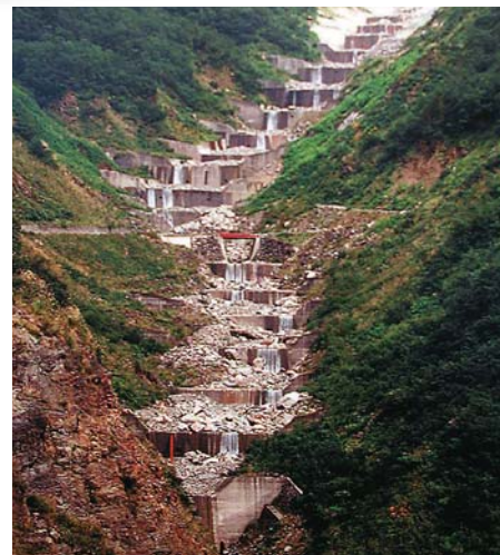
流出する土砂を抑える別当谷階段えん堤群
