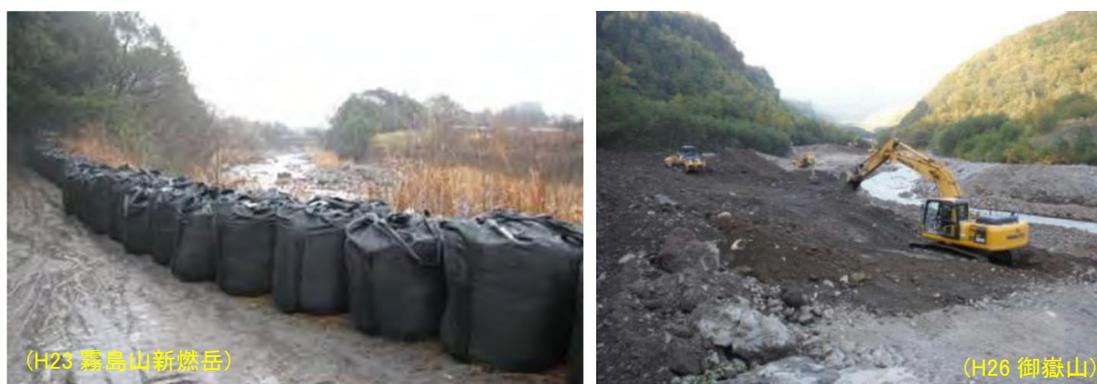
図 1.7 緊急ハード対策のイメージ（左：導流堤、右：治山堰堤堆砂敷の除石工事）
