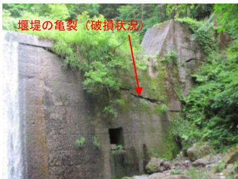
図 3.13 砂防施設の被災状態点検イメージ
