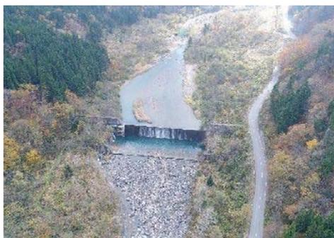
図 3.14 UAV 等による砂防施設の堆砂状況点検イメージ（白山市 河内谷下流砂防堰堤）
