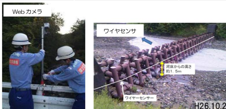
図 1.8 緊急ソフト対策としての機器設置イメージ
