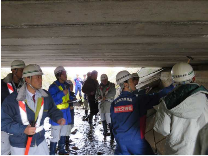
自治体管理橋梁で自治体職員自ら点検 (11月20日 石川県宝達志水町)
