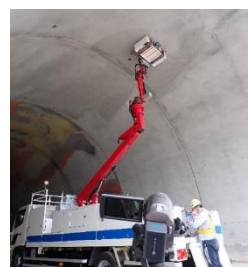
レーザー打音による変状の把握
