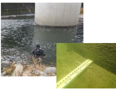
潜水調査による河床洗掘の把握
