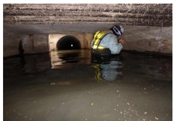
滞水した溝橋内部の目視点検
