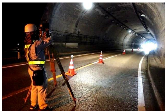
3次元レーザー計測作業状況
