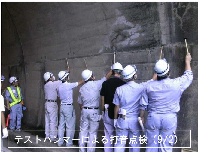
テストハンマーによる打音点検（9/2）
