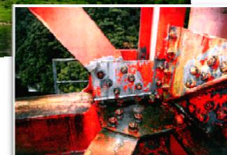
主桁の腐食
