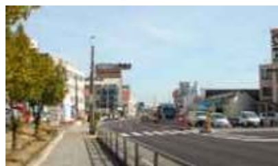
例:共同溝整備を行う・行った箇所
