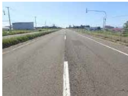
国道234号 岩見沢市栗沢付近 施工前の状況
