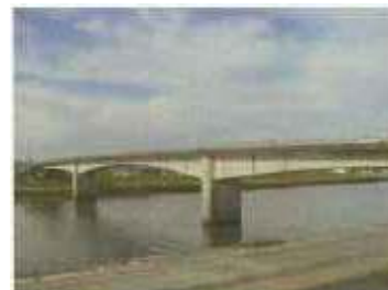
<天大橋の状況>
