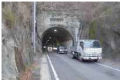
<仁方隧道の状況>
