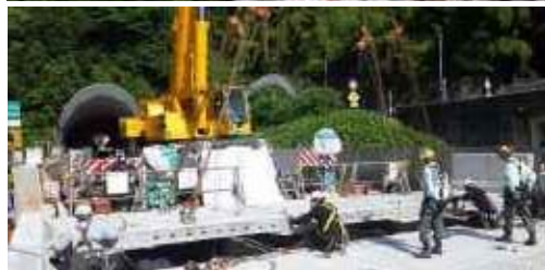
清水谷橋の施工状況(金沢森本IC～小矢部IC間)
