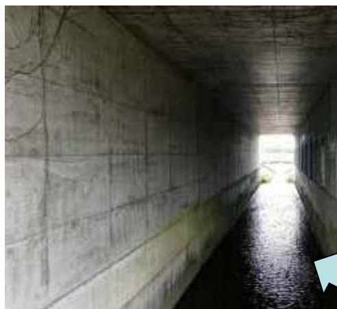
点検困難な水路BOX
