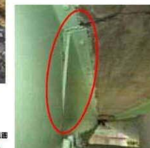
主桁の変形
