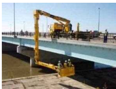
橋梁点検車による点検
