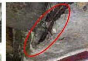
鉄筋の露出
