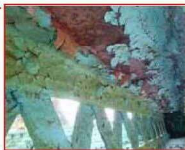
鋼材の腐食
