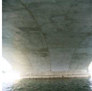
H19修繕後 (断面修復)
