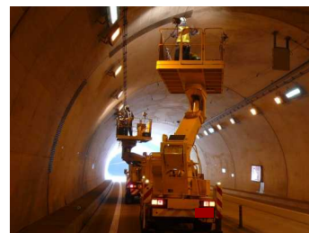
トンネル内 道路附属物点検
