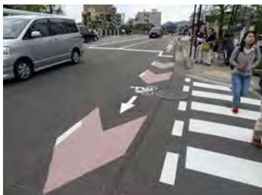
灰桜色の矢羽根に高輝度タイプの白線を設置（金沢市東山3丁目）
