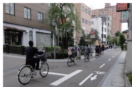
自転車走行指導帯の設置 (せせらぎ通り)
