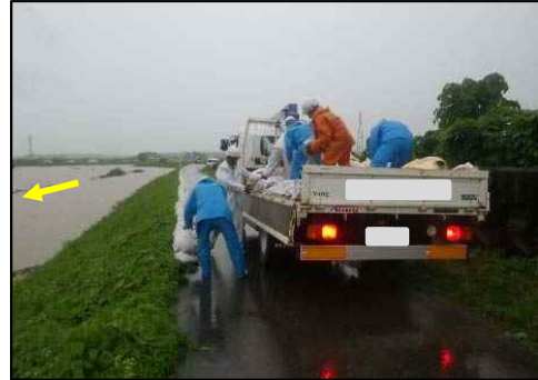
梯川左岸(佐々木町) 積み土のう工
