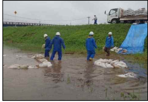
梯川左岸(荒木田町) 釜段工
