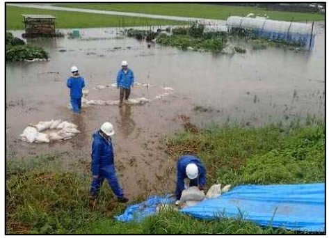
梯川左岸(荒木田町) 釜段工
