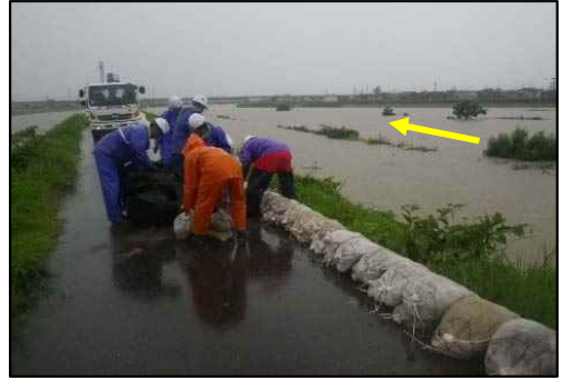
梯川左岸(佐々木町) 積み土のう工
