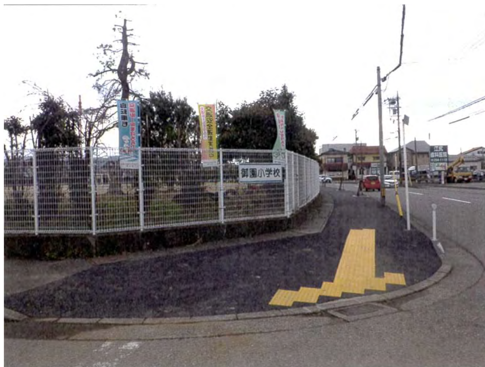
稲荷野代線歩道改良工事（令和4年度施工） 事業延長 L=480m 歩道幅員 W=3.5m（舗装幅員W=2.5m） 事業概要 開粒度アスコン A=1,173㎡
