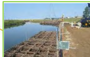
粗朶沈床施工状況(水際環境の創出)
