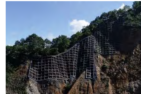
【治山 : 山腹工 (法枠工)】
