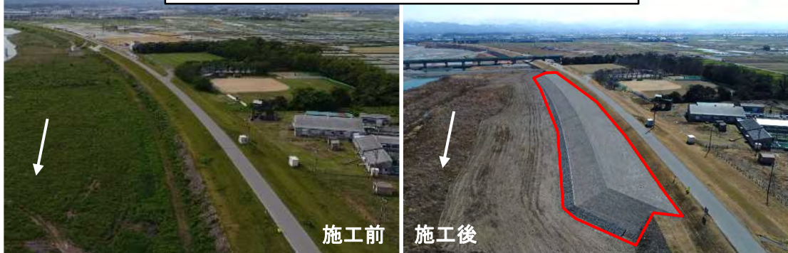
急流河川対策(根継護岸)：能美市 ミツロ地区(R3年度)
