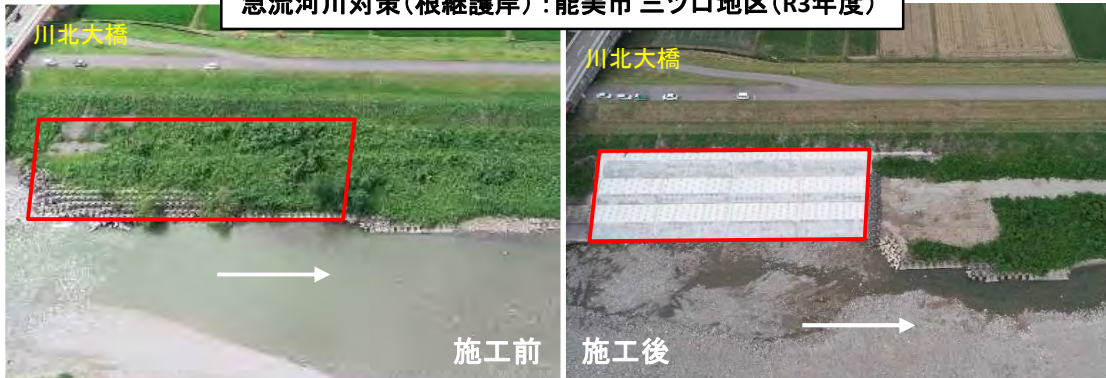
急流河川対策(根継護岸)：能美市 ミツロ地区(R3年度)
