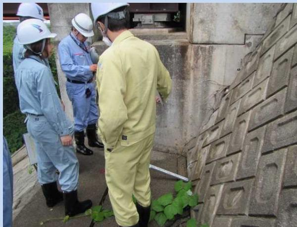
護岸天端の沈下(右岸9.8km)
