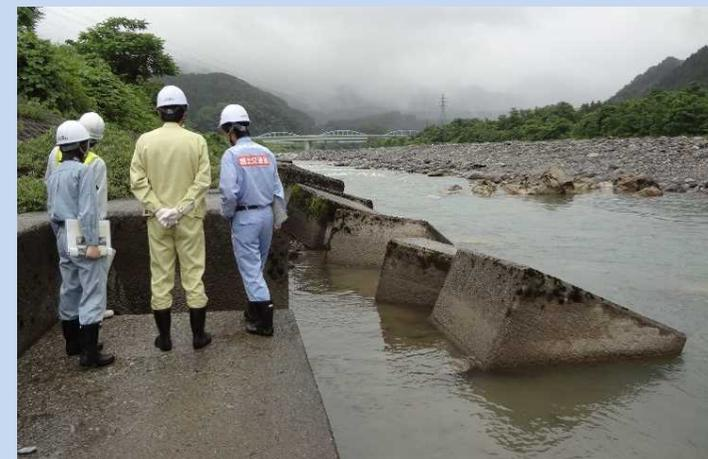
根固めブロックの変状(右岸15.0km付近)
