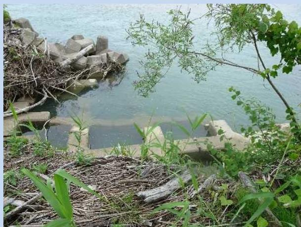
護床ブロック沈下(左岸3.6km付近)
