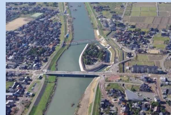
梯川分水路竣工（梯川・小松天満宮）
