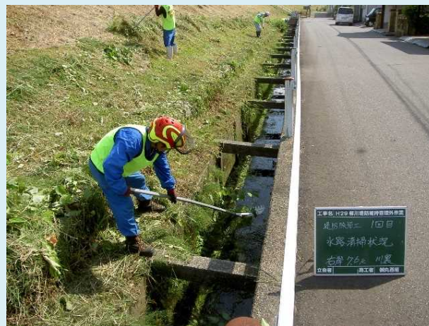
芝刈り後の水路清掃作業（梯川）
