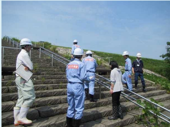
地域住民・自治体関係者を交えた点検（手取川）
