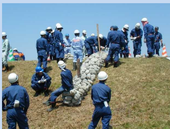
工法実技（立てかご工）
