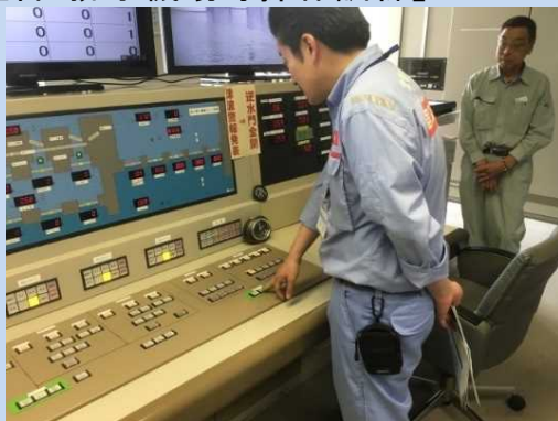
安産川樋管の ゲート操作（手取川）
