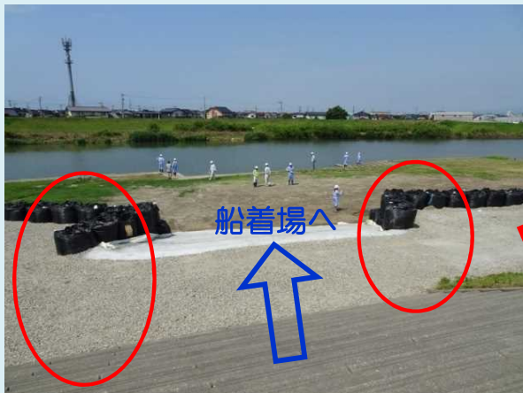
船着場と工事ヤードの間に仕切り無し（梯川）
