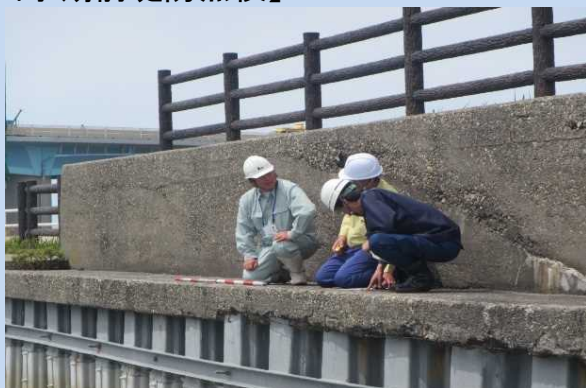
河口部護岸劣化状況の点検（手取川）
