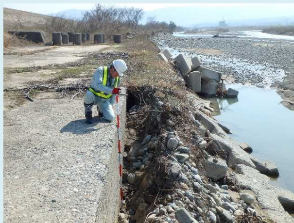
護岸などの目的別巡視（手取川）
