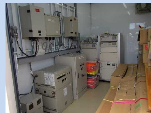
埴田水位観測所の観測機器（手取川）
