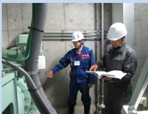
今江瀧排水機場設備の点検（梯川）
