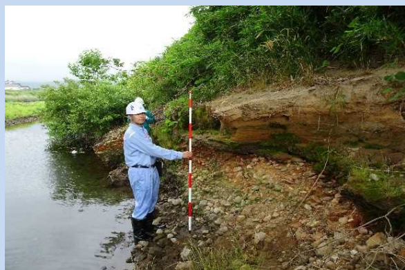
堤防下部の法面浸食状況の確認（梯川）
