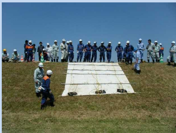
工法実技（シート張り工）
