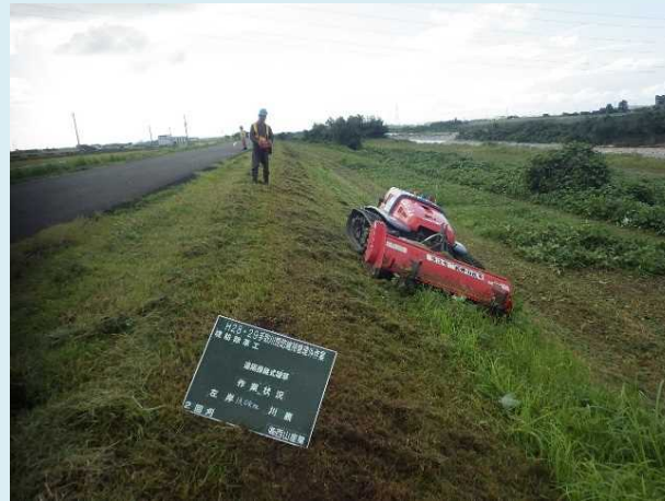
大型遠隔自走式機による除草作業（手取川）
