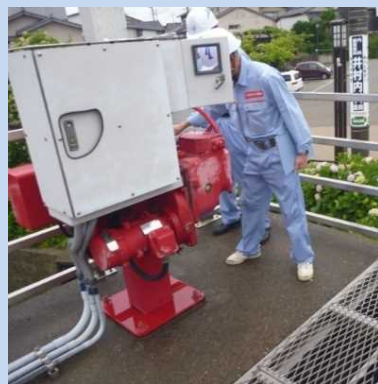
安産川樋管の ゲート操作（手取川）
