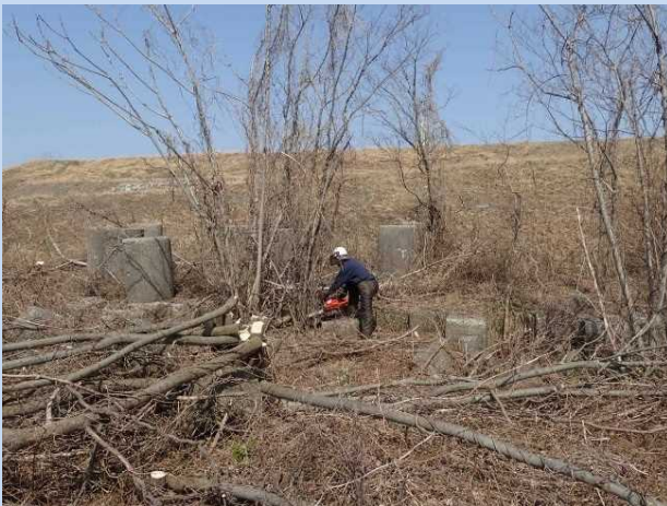
樹木伐採作業の様子
