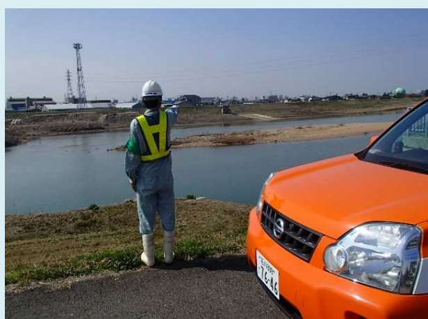
堤防道路上からの一般巡視（梯川）
