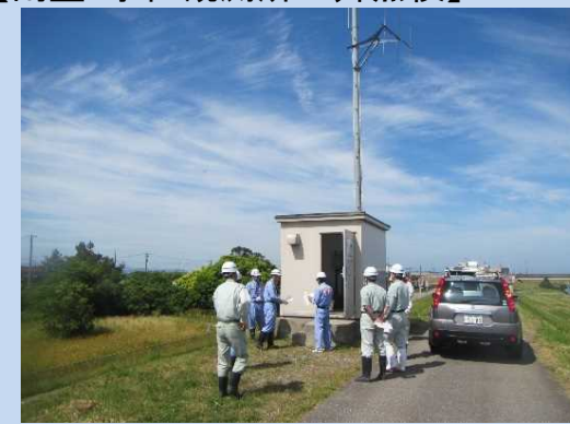
牧雨量観測所での点検（手取川）
