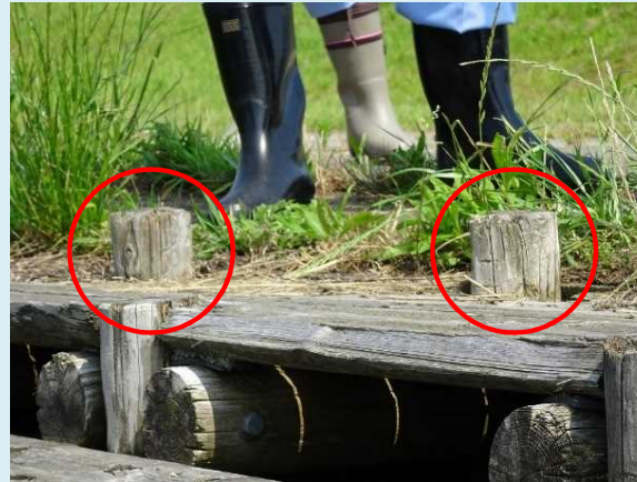
点検による木製階段の不具合確認（手取川）
