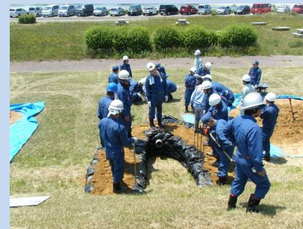
工法実技（月の輪工）
