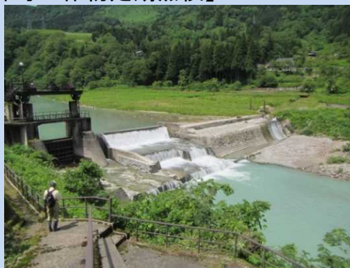
北陸電力発電用取水施設の点検（手取川）
