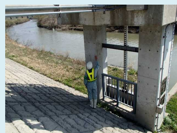
樋管などの目的別巡視（梯川）
