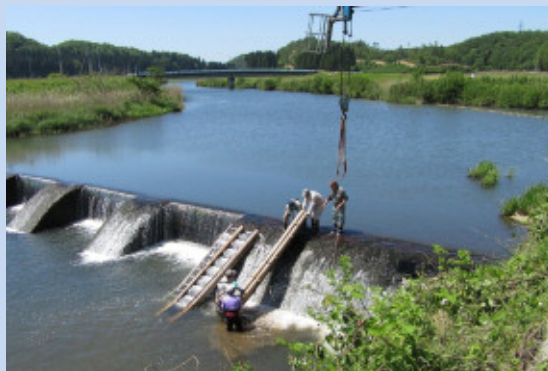
アユの魚道設置作業（梯川）
