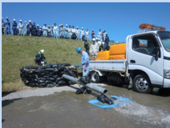
工法実技（月の輪工の排水実演）
