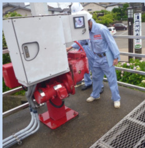
安産川樋門のゲート操作（手取川）
