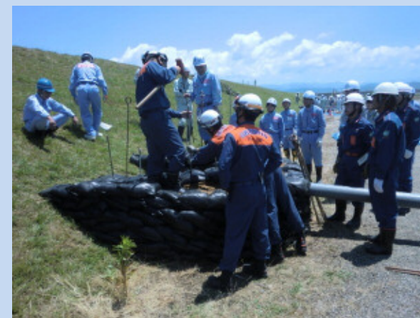
工法実技（奥能登消防署：月の輪工）
