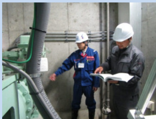
今江潟排水機場設備の点検（梯川）
