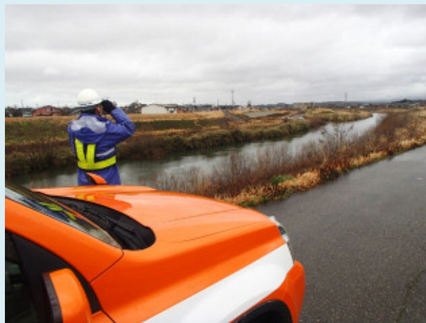
堤防道路上からの一般巡視（梯川）
