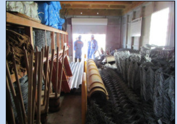
水防倉庫の点検（梯川）
