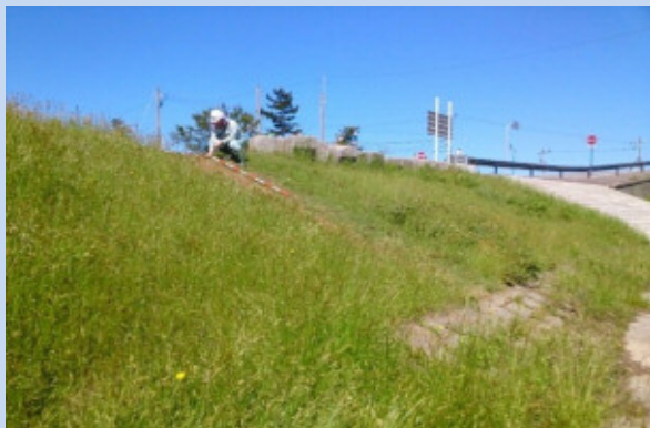
堤防の表面破損状況の点検（手取川）
