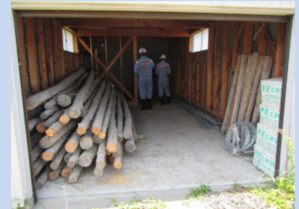
水防倉庫の点検（手取川）
