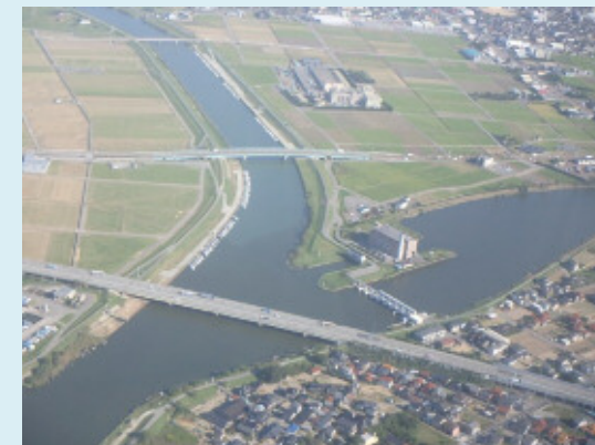
梯川1.Ok付近
