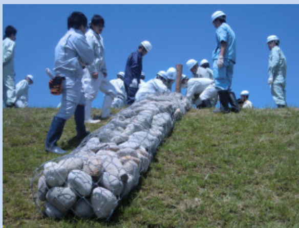
工法実技（石川県他：立てかご工）
