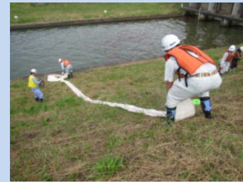
排水ホースの設営作業
