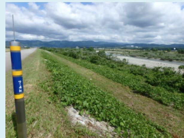
樹木繁茂の状況調査（手取川）
