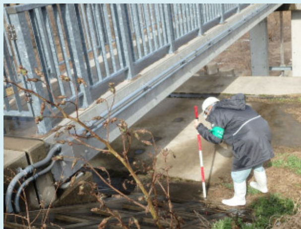
樋管などの目的別巡視（手取川）
