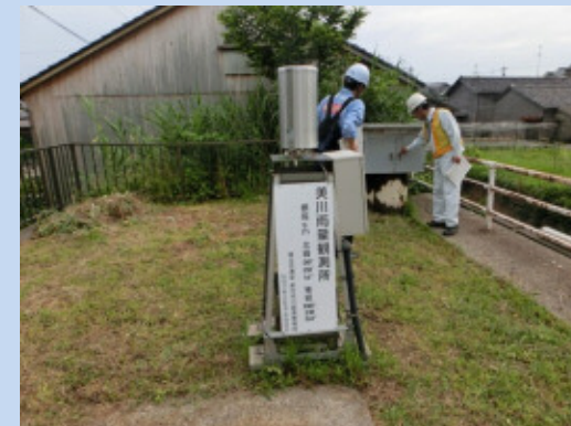
美川雨量観測所での点検（手取川）
