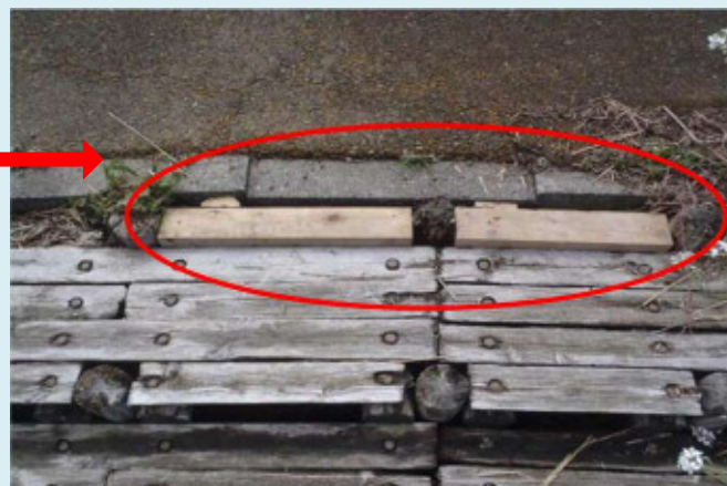
木材の代替えによる修繕（梯川）
