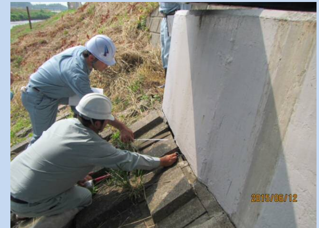
護岸とバット隙間，護岸沈下（梯川）
