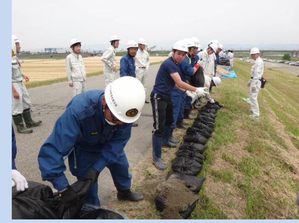
工法実技（白山市消防団：積み土のう工）
