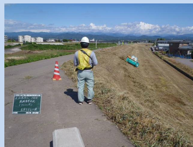
ラジコン式除草機による除草作業(梯川)
