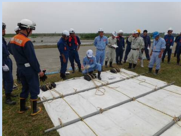
工法実技（加賀市消防署：シート張り工）
