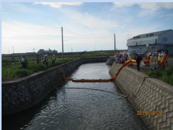
排水樋管上流でのオイルフェンス展張・撤去訓練
