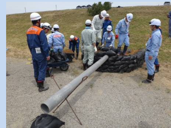
工法実技（奥能登消防署：月の輪工）
