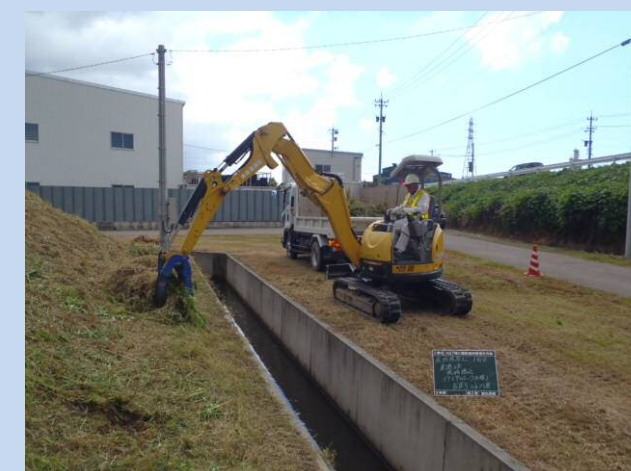
工作機械による集草・積込作業(梯川)
