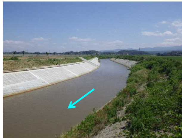
【堤防補強実施箇所】 鍋谷川 鍋谷川橋上流(左岸:小松市古府町 右岸:能美市牛島町)
