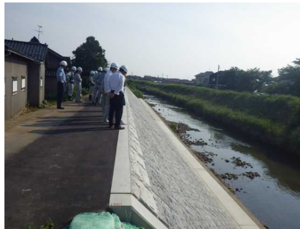
【南加賀土木 重要水防箇所】 八丁川（小松市長田町）
