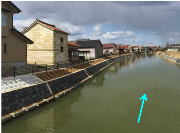
【河川改修実施箇所】 前川 今江新橋下流 (小松市今江町)
