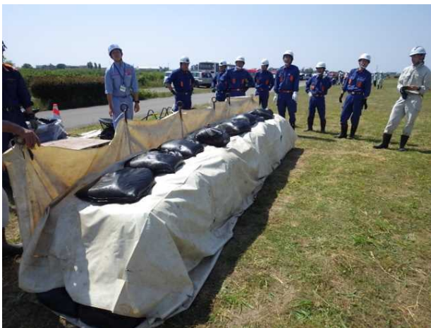
改良積み土のう工
