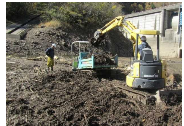
【③維持修繕工事の実施】 ダム貯水地内の流木を除去状況
