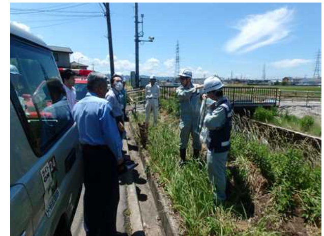
【石川土木 重要水防箇所】 高橋川（野々市市新庄1丁目）
