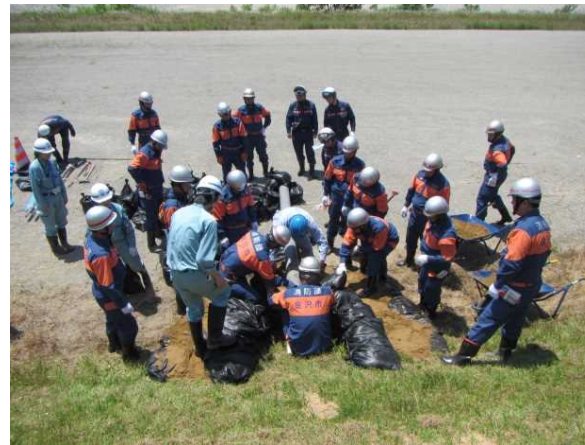
①月の輪工の実技
