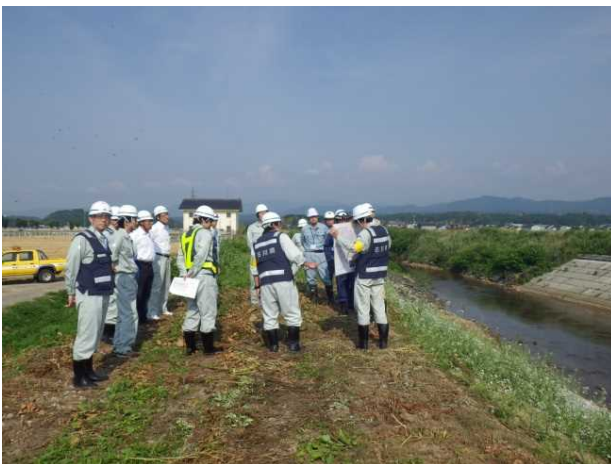
【南加賀土木 重要水防箇所】 鍋谷川（能美市佐野町）
