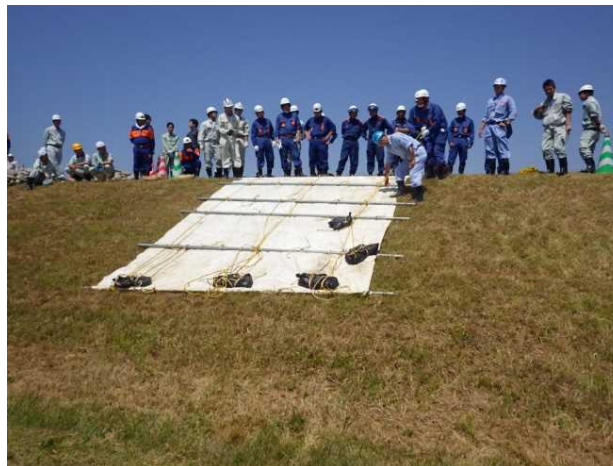
シート張り工
