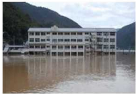
H26.8避難所2階の浸水 (徳島県)
