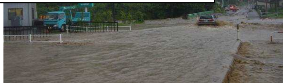
(主)金沢湯涌福光線の冠水状況(金沢市浅川町)
