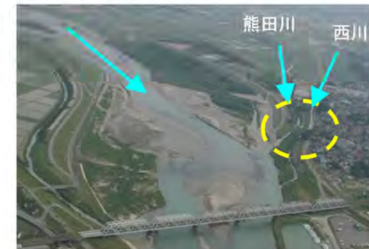
樋門設置箇所
