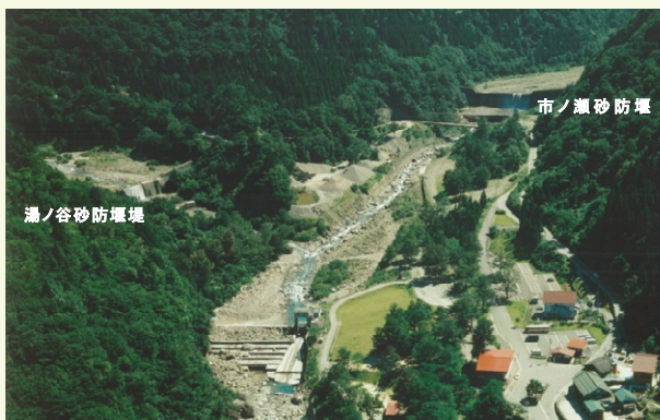
市ノ瀬（湯ノ谷合流点）市ノ瀬堰堤（昭和29年竣工）、湯ノ谷堰堤（昭和31年竣工）
