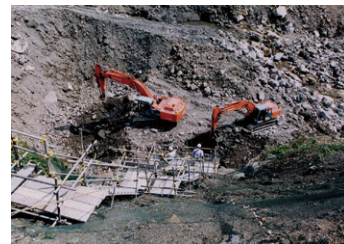
①無人バックホウによる掘削
