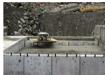
④コンクリートの締め固め
