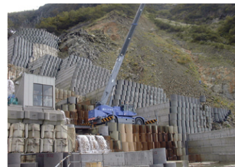
②無人クレーンによる円形ブロック据付
