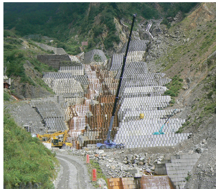
柳谷導流落差工 (工事期間：平成8年10月～平成19年11月)
