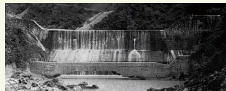
瀬戸堰堤（昭和27年竣工）
