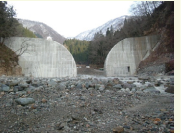
尾添川第2号砂防堰堤（平成19年竣工）
