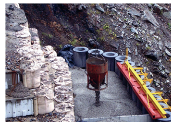
③コンクリート打設
