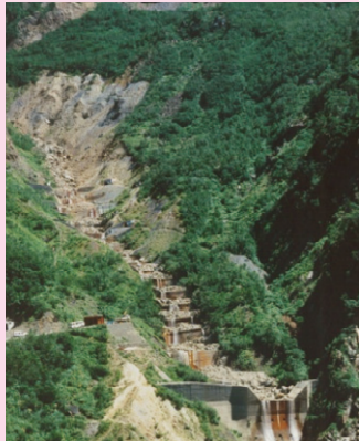
甚之助谷階段状堰堤（昭和6年～） 我国初期の階段状堰堤
