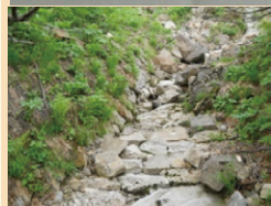
甚之助谷張石水路工（大正6年竣工）
