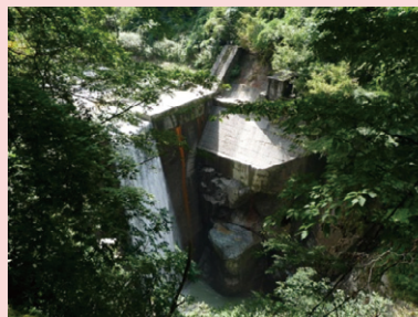
御鍋堰堤（昭和32年竣工）
