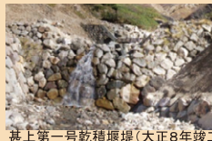
甚上第一号乾積堰堤（大正8年竣工） 白山砂防で現存する唯一の乾積堰堤
