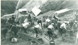
人力でコンクリートを製作・施工 現地にて採取した骨材とセメント・水の練混
