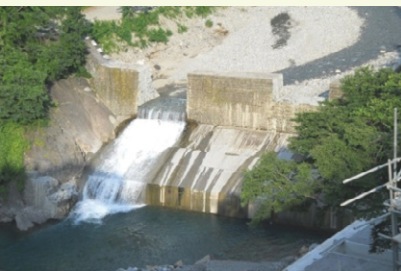
瀬戸堰堤（既設砂防堰堤のスリット化）
