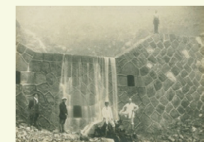
竜ヶ馬場溪第一号堰堤（大正15年竣工） 白山砂防で最も高所に造られた練石積堰堤。大正時代の練積堰堤として唯一竣工時のまま手を加えられていない。
