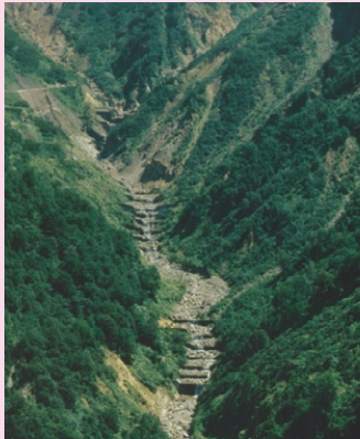
柳谷階段状堰堤（昭和2年～） 我国最初の階段状堰堤
