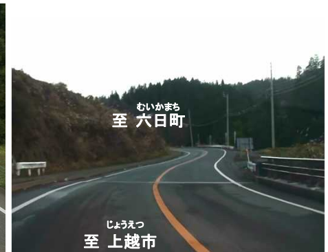
写真4-4 R253線形不良区間
