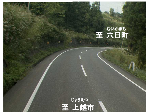
写真4-3 R253線形不良区間
