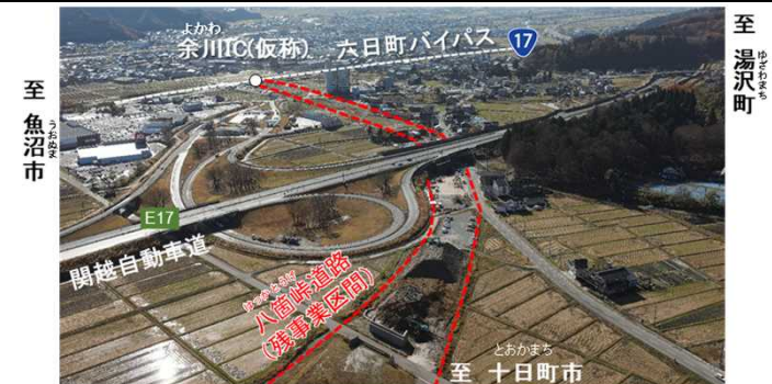
写真2-2 八箇峠道路 残事業区間
