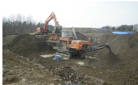
写真3-6 発生土の状況(改良後)
