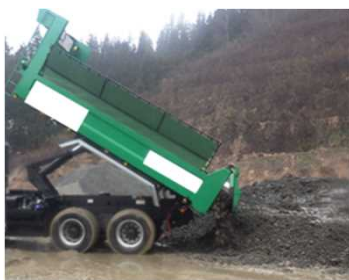
写真3-5 発生土の状況(改良前)
