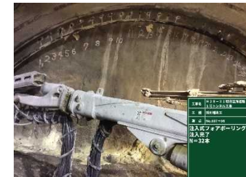
写真3-1 注入式フォアポーリング
