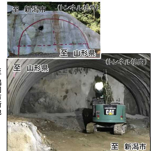
写真2-1 1号トンネル貫通状況 (R2.9 撮影)
