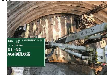
写真3-2 注入式長尺先受工
