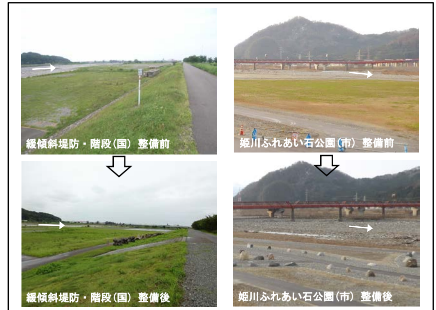
整備前後の状況(写真2-2)
